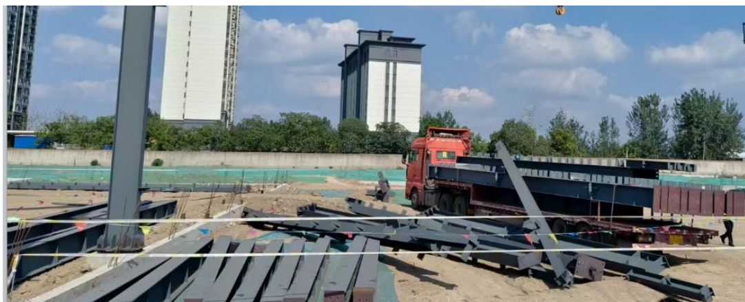
图6 现场钢结构堆放情况
