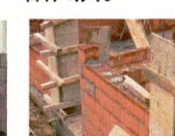
砌体结构、砖混结构应先砌墙后浇柱(✓)
